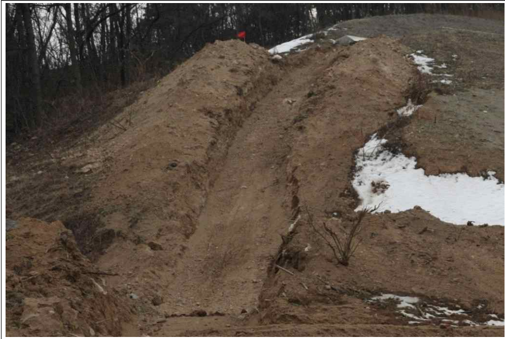
【그림 5】 종점부 산마루배수구 시공사진
