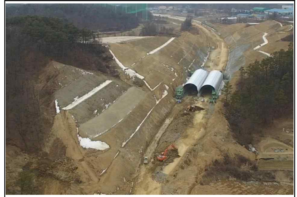
【그림 4】 깎기비탈면 종점부 측면 사진
